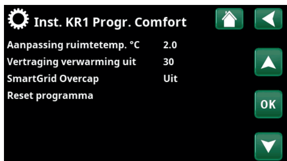
Menu "Installateur/Instellingen/Verwarmingskring/Verwarmingskring 1/Programma/Comfort".
