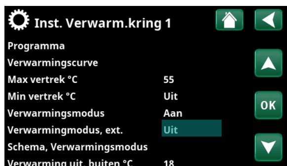
Menu: "Geavanceerd/Instellingen/Verwarmingskring/Verwarmingskring 1" Afstandsbedieningsmode "Uit" wordt actief wanneer klem K24 sluit.
