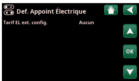
Menu : «Installateur/Défini/Appoint électrique».
