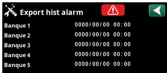
Menu : «Installateur/Service/Export hist alarm»
